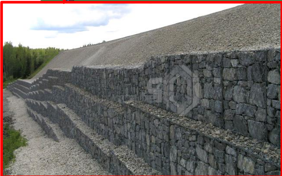
Подпорные стены из габионов
